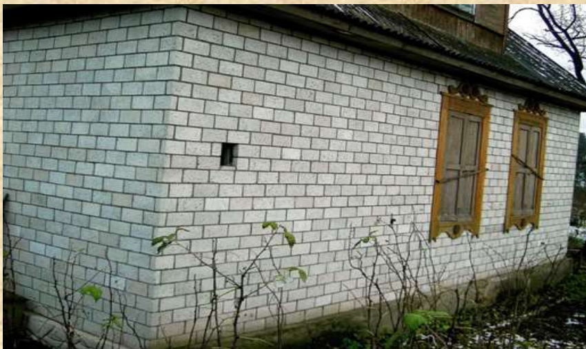
Стеновой отделочный материал из отходов картонажного производства
